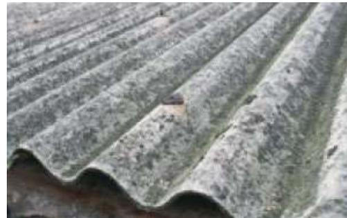
Plaques de toiture en amiante-ciment
